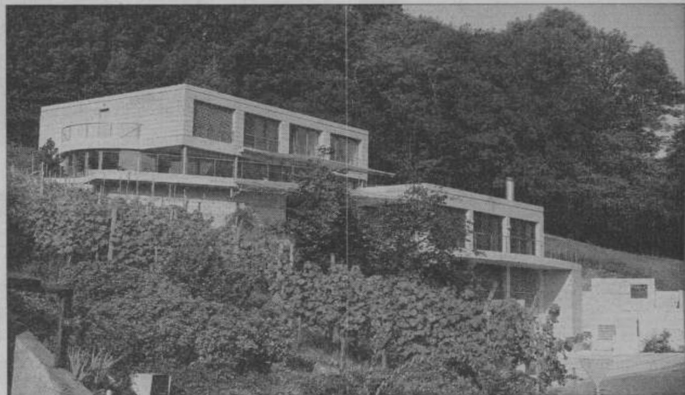
Ausdrucksvolle Architektur in eindrücklicher Umgebung: Ein Neubau in Stäfa. (Bild pd)
